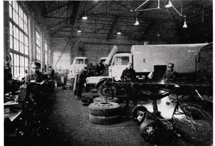
LKW-Halle Werk I
