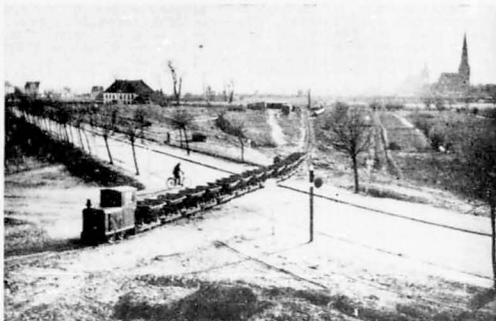
Links: Vom Tierförwer Berg befördern die Loren die Erdmassen, die am Osthafen aufgeschüttet werden, rechts: Gleisarbeiten.
