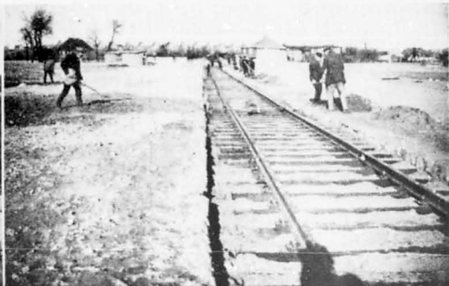
Links: Vom Tierförwer Berg befördern die Loren die Erdmassen, die am Osthafen aufgeschüttet werden, rechts: Gleisarbeiten.
